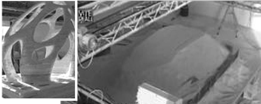
D-Shape 프린터로 프린팅한 비정형 건축물(D-Shape).
